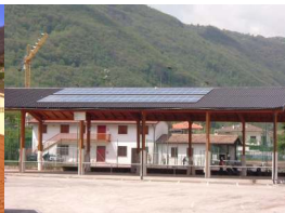
Impianto solare termico presso la palestra comunale sita in piazza Mercato
